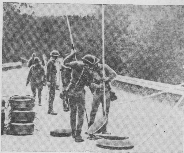
Рис. 1. Подготовка участка дороги к разрушению взрывом
