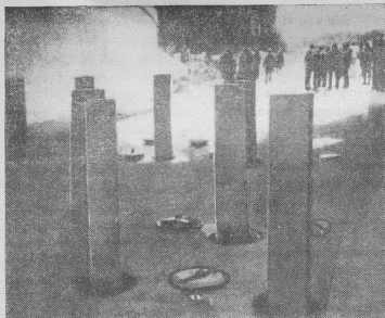
Рис. 2. Невзрывное заграждение на дороге из вертикальных надолб
